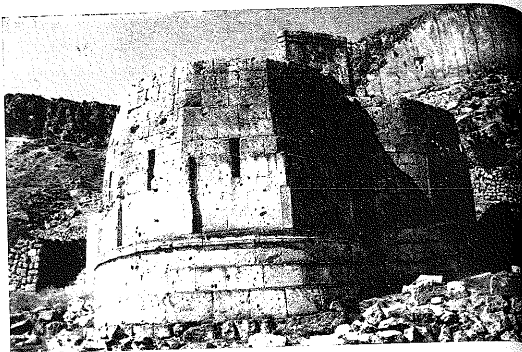
Fig. 15. — SAINT-GEORGES D'ORTAKÖY. Extérieur, vue nord-est (XIII e siècle?).
